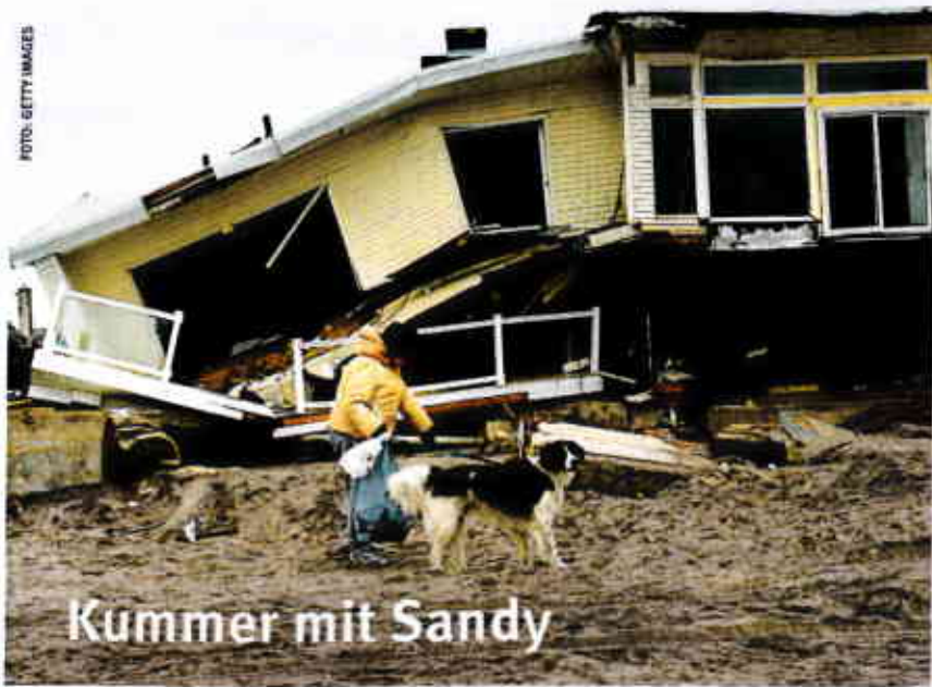
Sturmschäden durch Hurrikan Sandy im Herbst 2012 am Strand von New York
